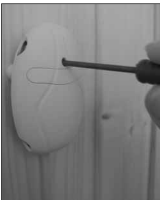
Joonis 14. Ülekuumenemiskaitse tagastusnupp
